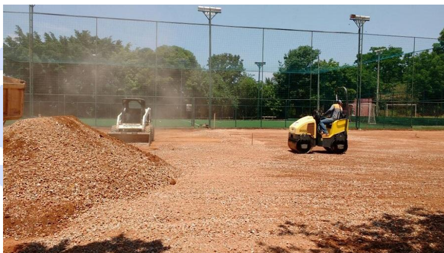
Figura 5 - Utilização do RCD reciclado (bica corrida) na terraplanagem de um estacionamento.
