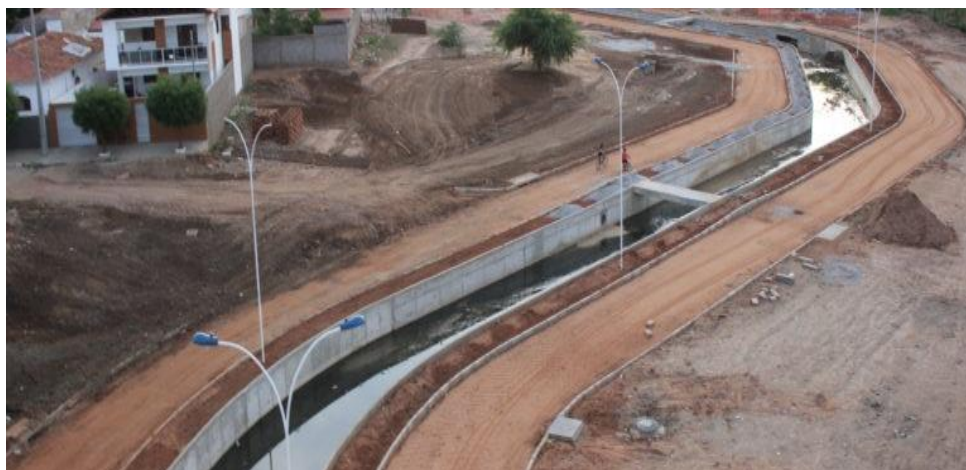
Figura 2: Sistema de macrodrenagem – Córrego canalizado em área urbana.
