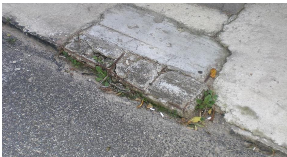
Figura 10: Acúmulo de resíduos de construções nas bocas de lobo.
